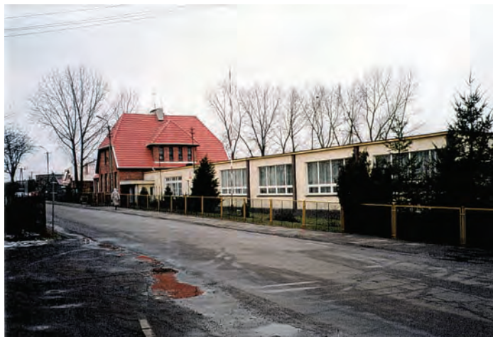
Budynek SP Niemcz przy ul. Bydgoskiej (pawilon z 1968 r.)
